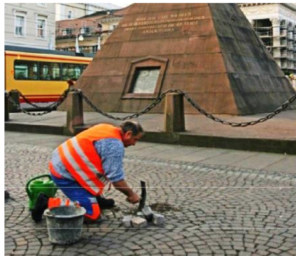
Belagsausbesserungen in der Fußgängerzone
